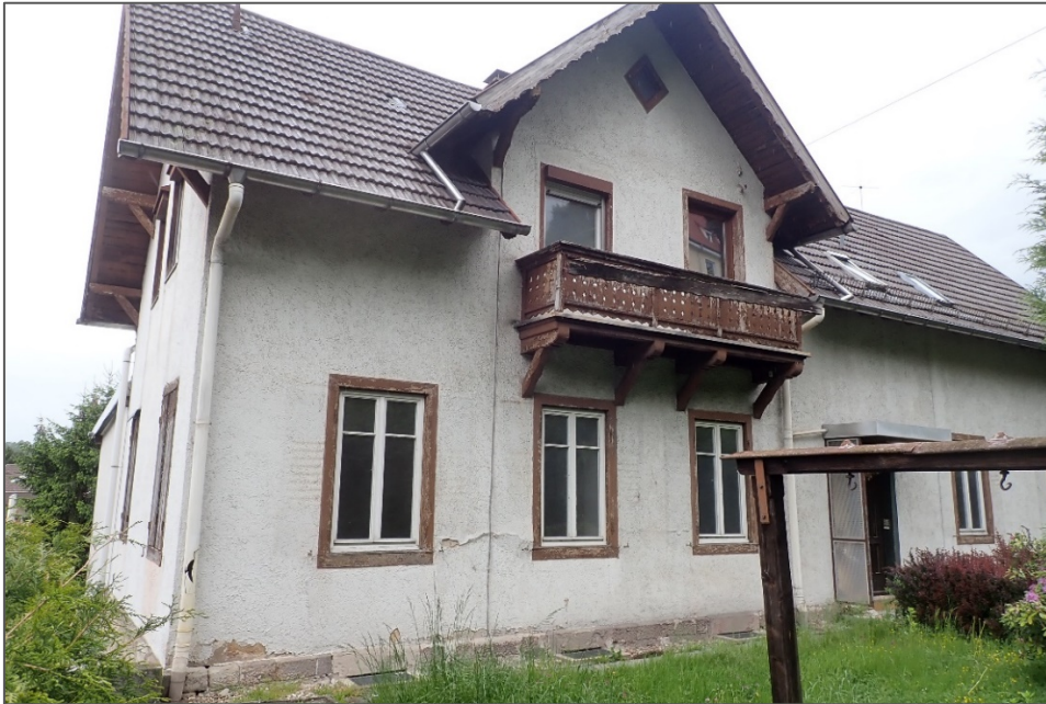
Abb. 4: Bestehendes Gebäude (Südseite)
