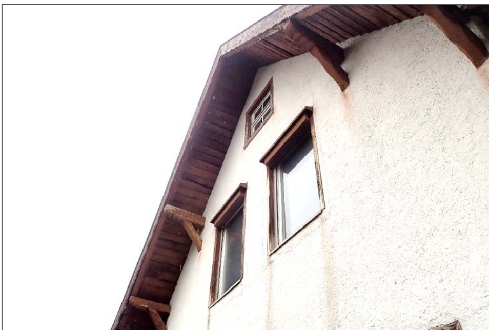
Abb. 5: Spaltenreiche Holzverkleidung am Dachtrauf
