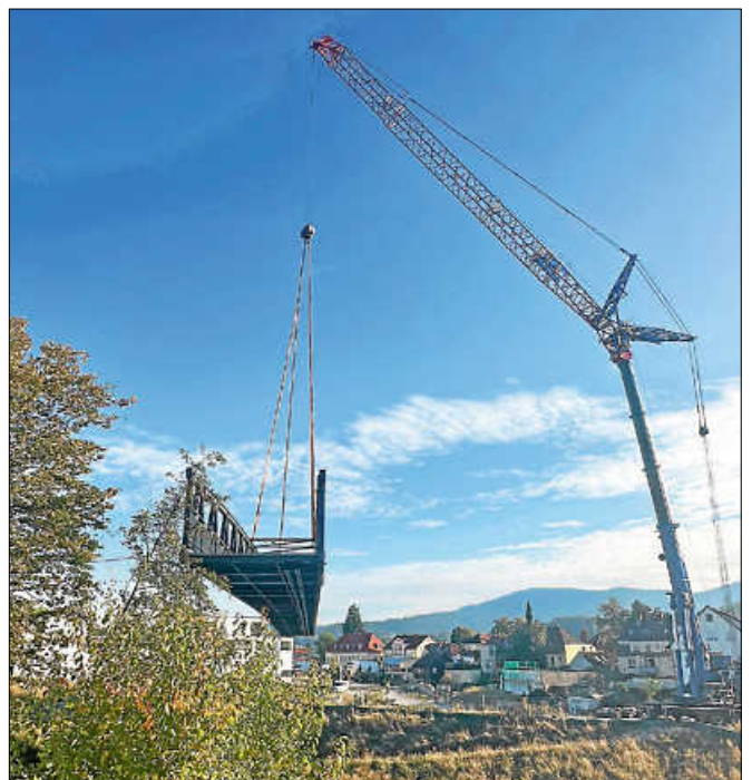
Einhebung der Brücke
