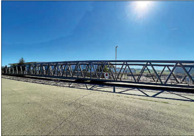
Die Brücke im Zwischenlager bei Oberndorf.
