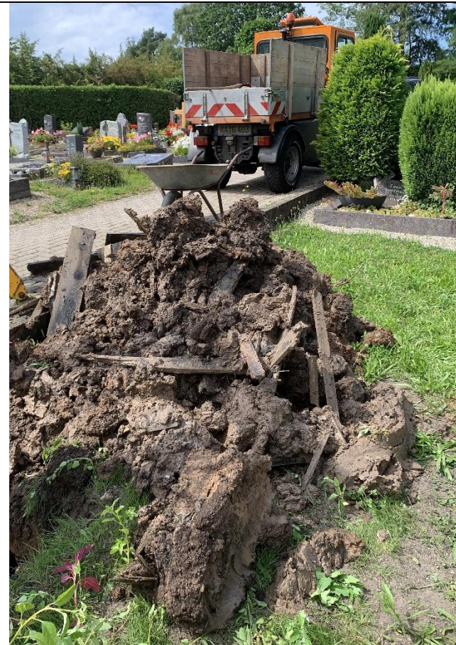
Abb. 5: Bodenaushub Schurf 3 mit Sargresten (Foto: Glomb, 01.10.2024)
