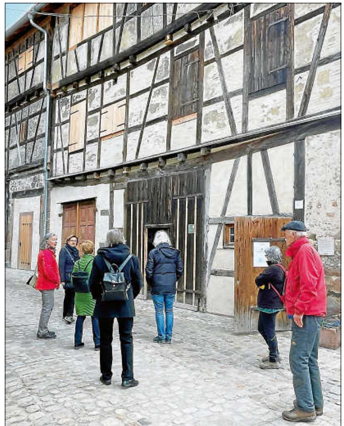
Architekt Bernd Säubert gab den Stadtführerinnen und Stadtführern einen kompetenten Einblick in die Historie der Zehntscheuern. Foto: Regina Meier
