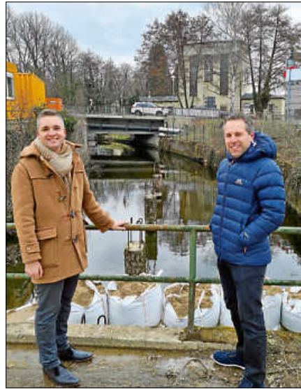
Bürgermeister Julian Christ und Bauamtsleiter Jörg Bauer betrachten den Einsatz von BigPacks, die zur Trockenlegung des Kanals eingesetzt werden. Foto: Stadt Gernsbach
