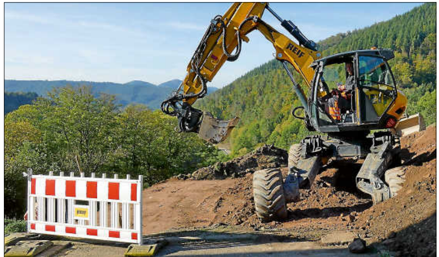
Erschließungsarbeiten für das Baugebiet.
