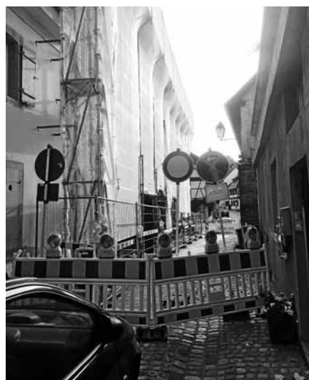
Sanierungsmaßnahmen. Foto: Zehntscheuern
