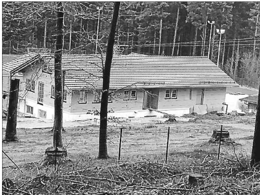
Bauarbeiten in der Auwiesenhütte sind beendet.
