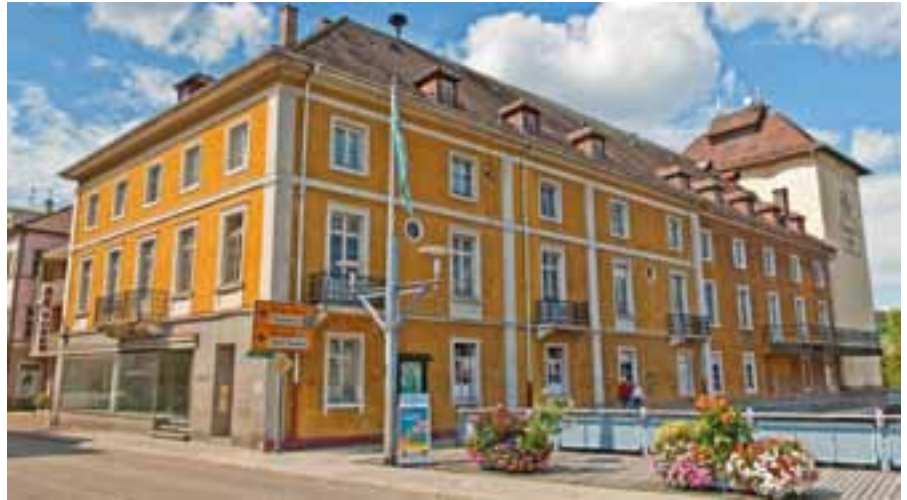
Die denkmalgeschützte Brückenmühle liegt im Sanierungsgebiet Innenstadt Mitte II. Der überhöhte Kaufpreis war Grund, dem Immobiliengeschäft die Zustimmung zu versagen.
