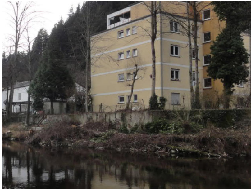
Abbildung 4.1 Mauer entlang der Murg im Bereich der Murginsel in Gernsbach
