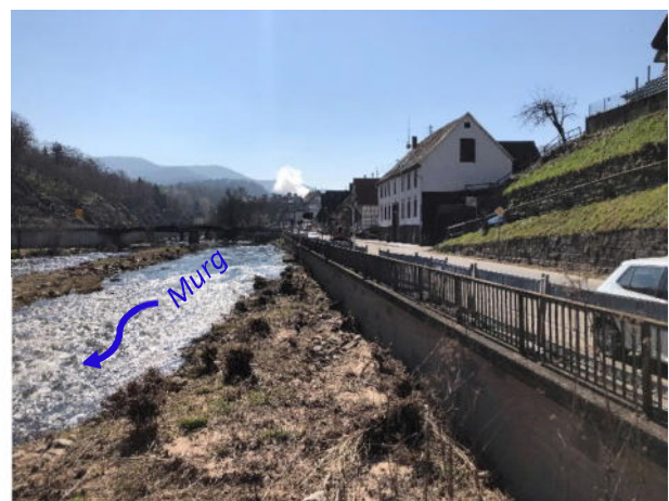
Abbildung 5.5 Vorhandene Ufermauer entlang der Obertsroter Str., Bereich geplante Erhöhung der Ufermauer (beide Fotos)
