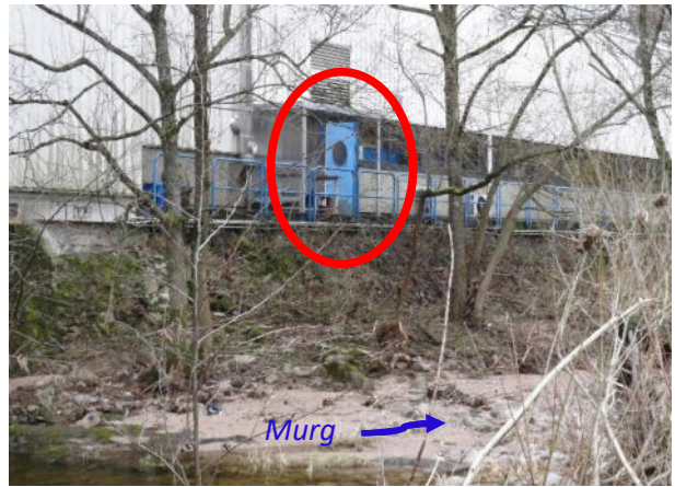
Abbildung 5.2 Vorhandene Ufermauer und Entwässerungsrohre im Bereich der Fa. Röchling, Bereich geplante Erhöhung der Ufermauer (linkes Foto); Gebäude der Fa. Röchling, Bereich erforderliches Dammbalkenelement an der Eingangstüre (rechtes Foto)
