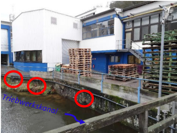
Abbildung 5.2 Vorhandene Ufermauer und Entwässerungsrohre im Bereich der Fa. Röchling, Bereich geplante Erhöhung der Ufermauer (linkes Foto); Gebäude der Fa. Röchling, Bereich erforderliches Dammbalkenelement an der Eingangstüre (rechtes Foto)
