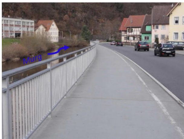
Abbildung 5.13 Auskragender Gehweg parallel zur B 462 oberhalb der Bebauung Murgtalstr. 2 - 16, Bereich geplanter Betonbrüstung (Foto links); Geländer entlang der Murg oberhalb der Bebauung Murgtalstr. 2 - 16, Bereich geplante Winkelstützmauer (Foto rechts)
