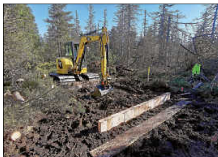
Zur Moorvernässung werden Grabensperren in Entwässerungsgräben eingebaut.
