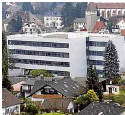
Die Fachräume Chemie und Biologie am ASG werden modernisiert. Foto: Stadt Gernsbach
