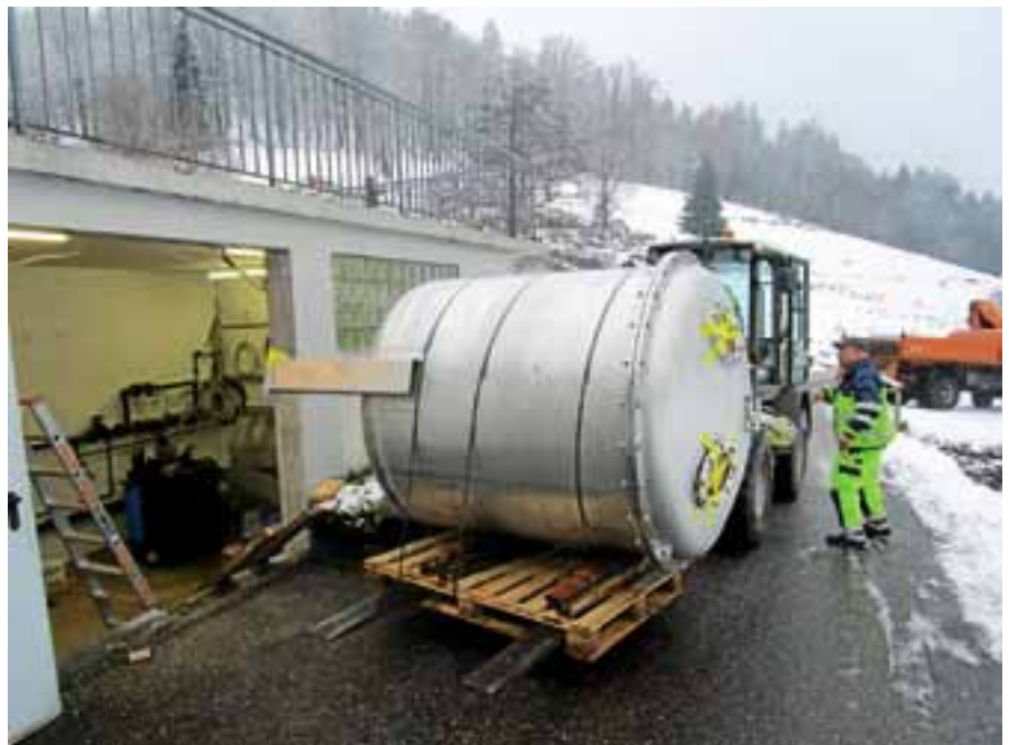
Der neue Filterkessel wurde mit Hilfe des Bauhofs eingebracht.
