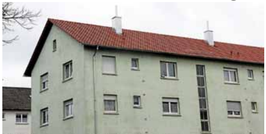
Am städtischen Zwölf-Familien-Wohnhaus in der Jakob-Kast-Straße 6 - 8 konnte die Erneuerung der Dacheindeckung noch vor Weihnachten abgeschlossen werden. Das noch von 1953 stammende Dach des Hauses war baufällig und wurde deshalb komplett saniert. Im Zuge der Maßnahme fanden auch Klempnerarbeiten an der Dachrinne statt. Ebenso wurden die Schornsteinköpfe mit Blech verkleidet. Der Gemeinderat hatte die Arbeiten in seiner Sitzung vom 26. Oktober an ein ortsansässiges Unternehmen vergeben. Die Kosten belaufen sich auf rund 68.000 Euro. ■
