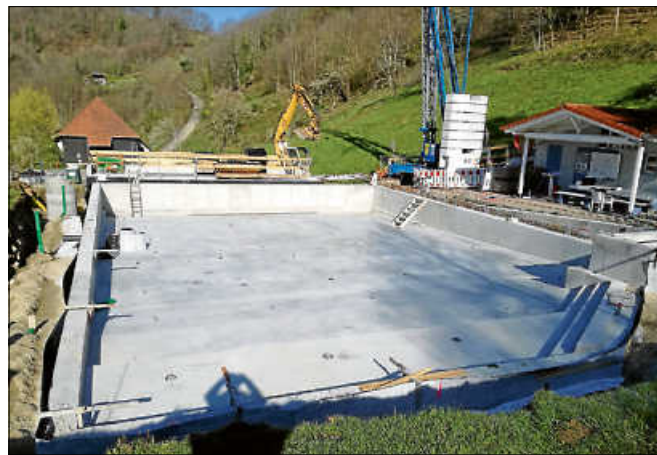
Das neue Schwimmbecken wurde bereits betoniert.
