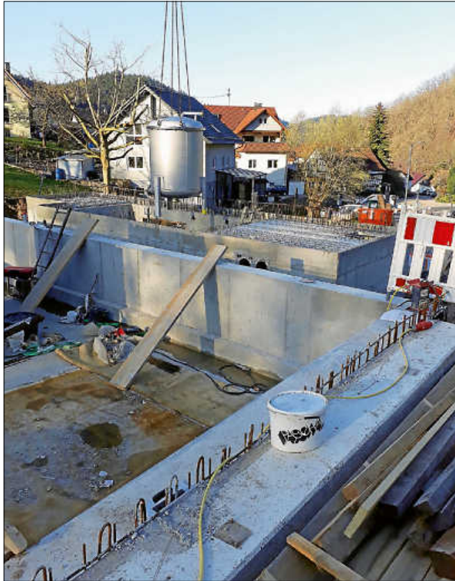
Der neue Anschwemmfilter wird ins Technikgebäude eingesetzt.
