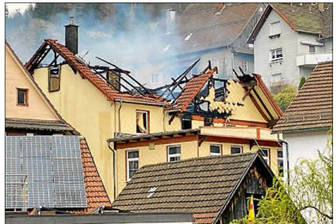
Großbrand in Gernsbach Reichental. Foto: Stadt Gernsbach
