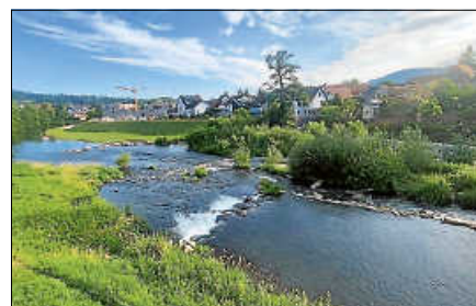
Der Auftrag für den Stegbau wurde vergeben. Foto: Stadt Gernsbach
