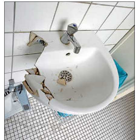
Das demolierte Waschbecken.
