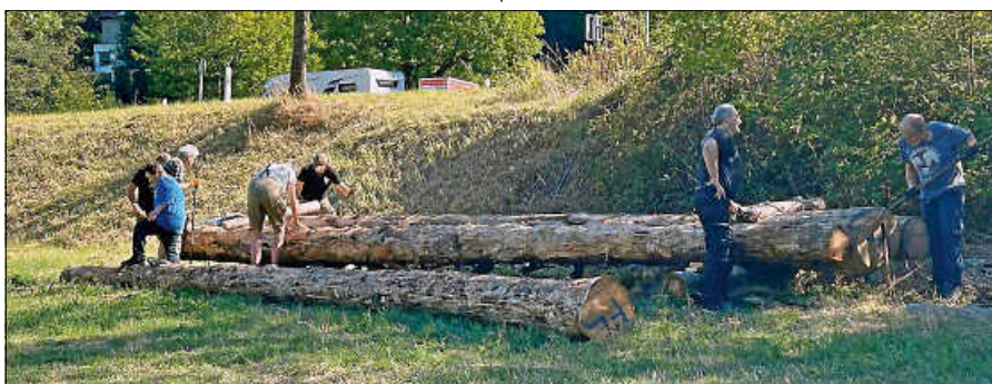
Die Aktiven bei der Arbeit am Holz für den neuen Anleger.
