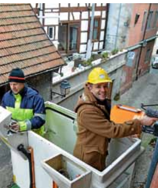
Bürgermeister Julian Christ gab den Startschuss für die Hauptsanierung der Zehntscheuern. Foto: Stadt Gernsbach
