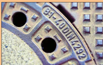
Die Straßenabläufe dienen dem Sammeln und Ableiten von Niederschlagswasser in die Kanalisation. Foto: Pixabay
