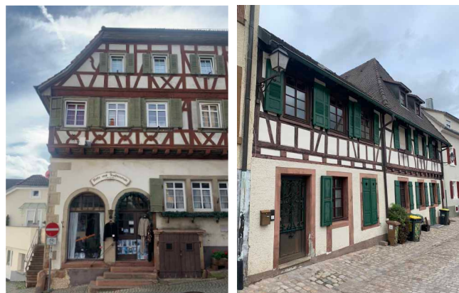
Abb.22 Hauptstraße 29 und Amtstraße 18, Beispiele Sichtfachwerkfassaden (ISA, 2023)
