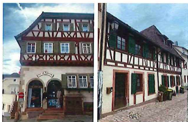
Abb.22 Hauptstraße 29 und Amtstraße 18, Beispiele Sichtfachwerkfassaden (ISA, 2023)
