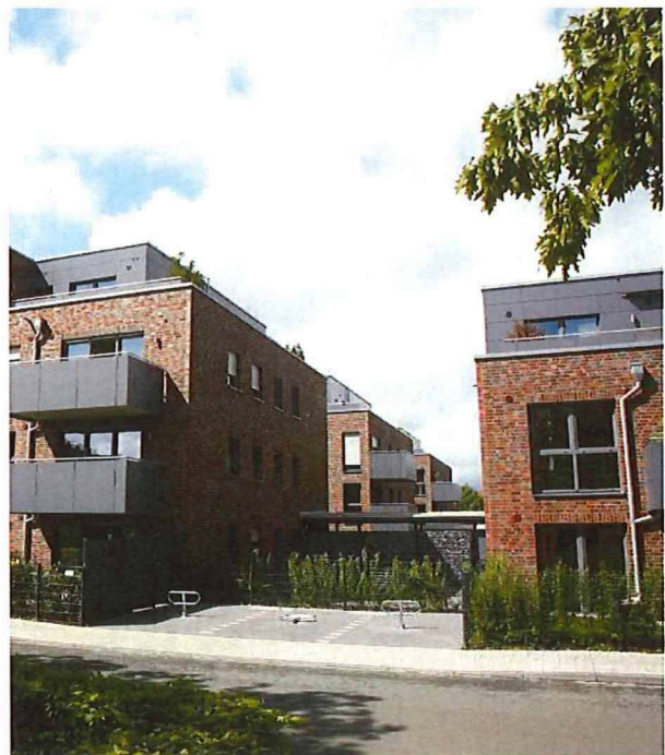
Bauen im Siedlungsbestand genießt Vorrang – Im Bild ein Neubauvorhaben an der Elbestraße
