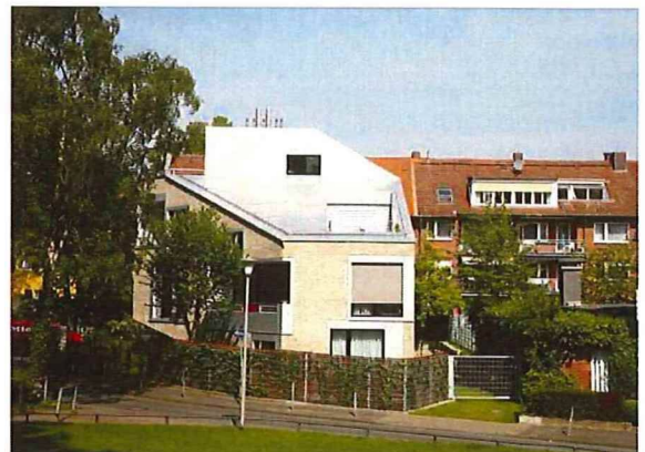
Wohnungsneubau im Siedlungsbestand – im Bild Projekte am Sauerländer Weg (oben) und an der Kleimannstraße (unten)
