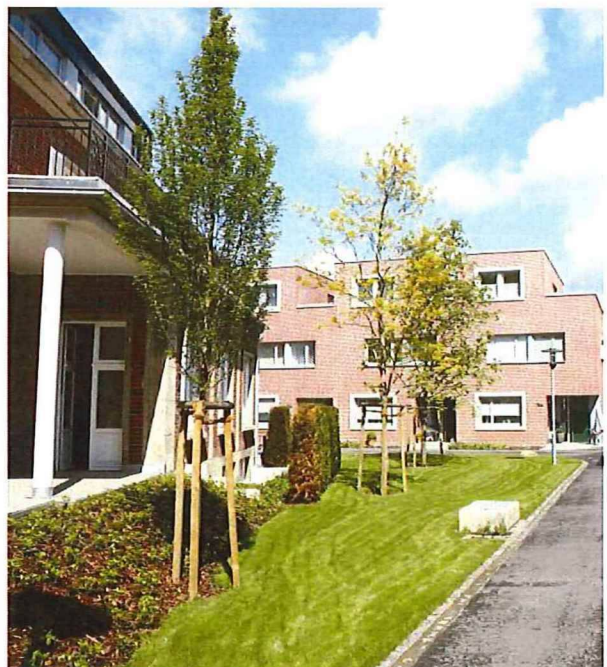
Neubauprojekt in Verbindung mit der Sanierung einer denkmalgeschützten Villa in Münsters Innenstadt - im Bild der „Piushof“
