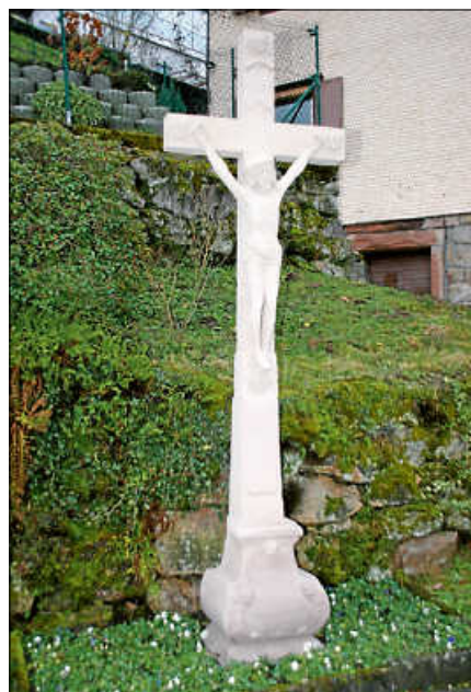
Das Wegkreuz am Hailweg nach der gelungenen Sanierung.
