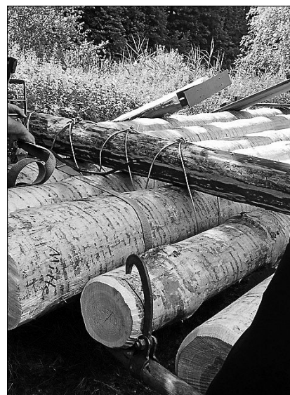
Der Bau eines Murgfloßes. Foto: privat
