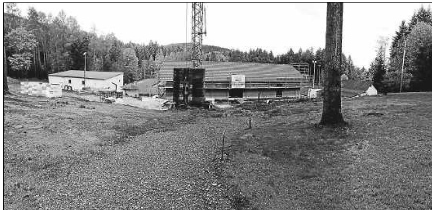
Weiterer Fortschritt der Auwiesenhütte.
