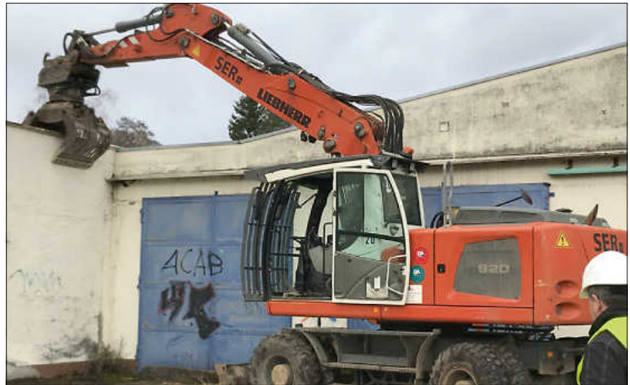
Start der Abrissarbeiten im Januar 2020.
