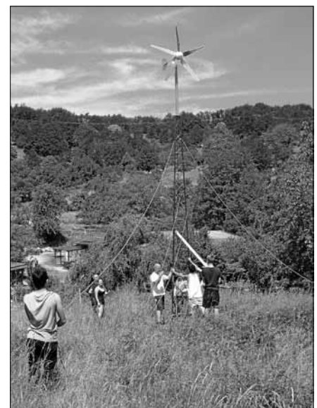
Bau eines Windrades auf dem Weidenhof gemeinsam mit SchülerInnen der HLA Gernsbach Foto: Frauke Kess
