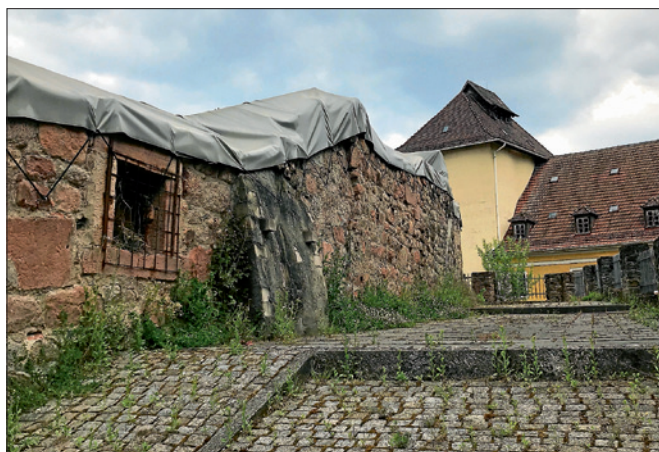
Die Stadtmauer wird saniert und auch der Zwinger wird wieder für die Öffentlichkeit zugänglich gemacht.
