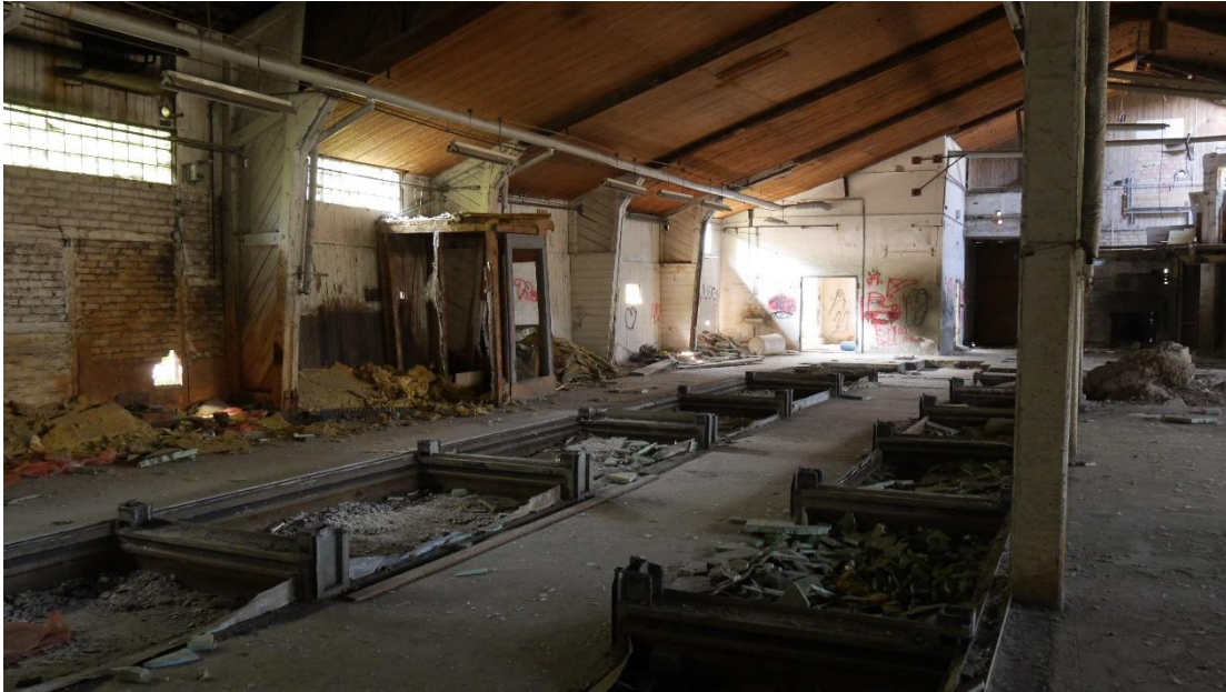
Photo 1: Standort Mitte, großflächige Verschalung der Decke
