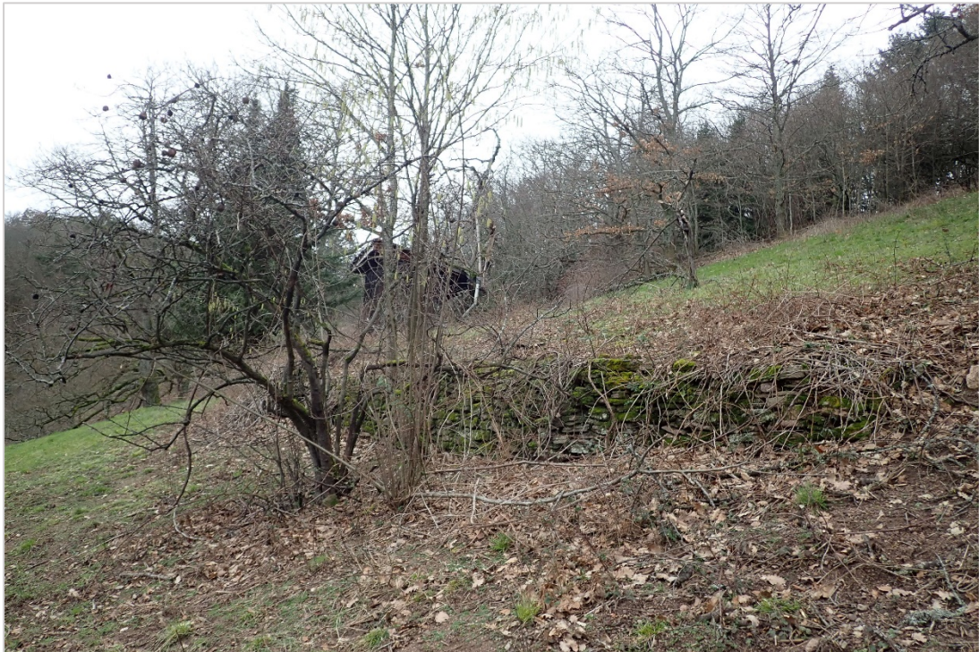
Abb. 5: Teilbeschattete zentrale Trockenmauer
