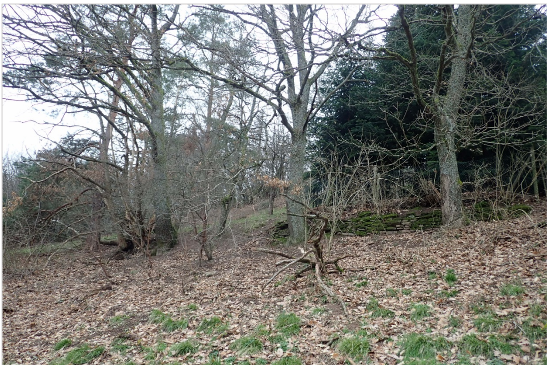
Abb. 6: Stark beschattete Trockenmauer im Norden
