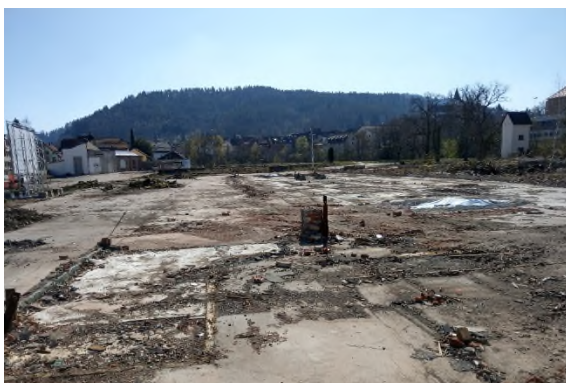
Bild 13: Südlicher Teil des Plangebietes nach Räumung (2020)
