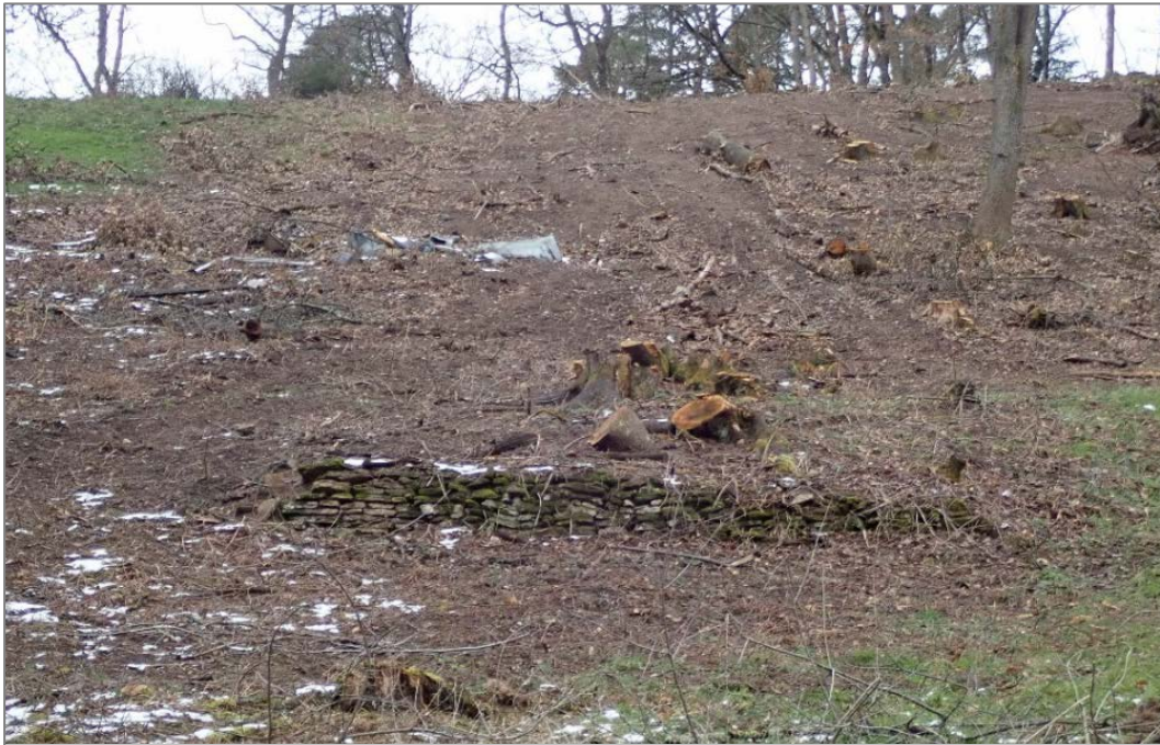
Abb. 5: Vorhandene, freigestellte Trockenmauer
