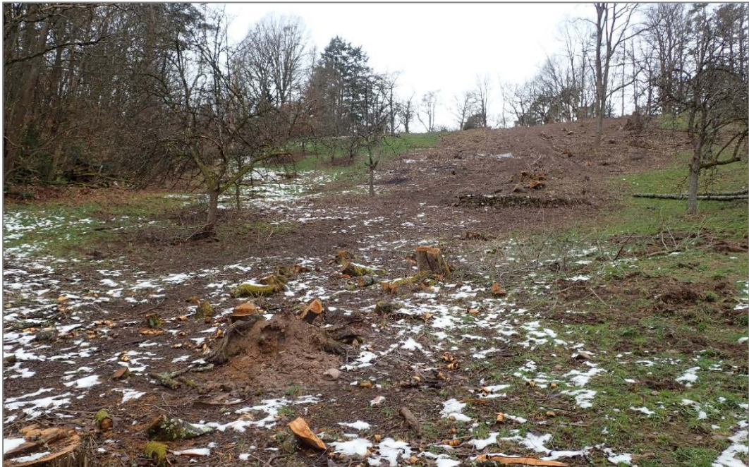
Abb. 2: Ausprägung des Ersatzlebensraums (v.a. Flurstücke 1231, 1233, 1234) im Februar 2021 nach der Gehölzentfernung
