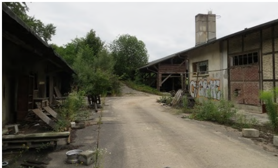
Bild 2: Ehemalige Produktionshallen (Foto 2017)
