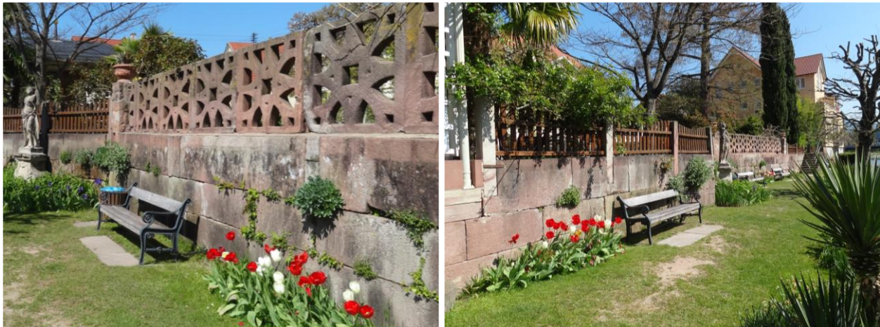
Abbildung 3.3 Bestehende wasserseitige Ufermauer mit wertvoller, gotischer Balustrade (links)
