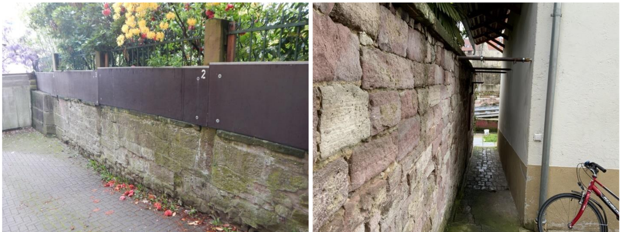
Abbildung 3.2 Bestehende Ufermauer bei Zu-/Abfahrt Tiefgarage (links); Abgestützte Mauer an das nördlich angrenzende Gebäude (rechts)
