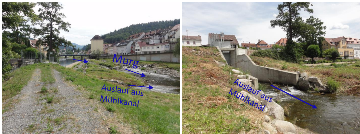
Abbildung 5.1 Beginn der Gewässeraufweitung unterstromig des Auslaufs aus dem Mühlkanal Sägmühle
