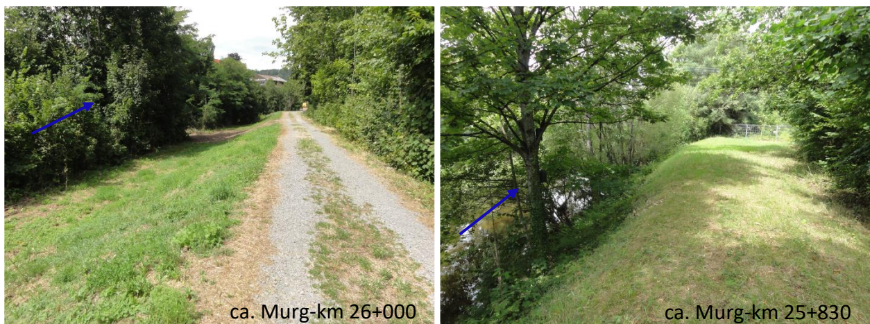
Abbildung 5.2 Bestehender Wirtschaftsweg und Damm auf dem Pfeleiderer-Areal
