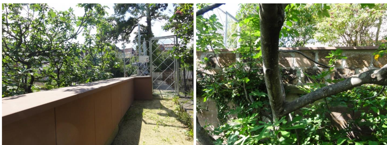
Abbildung 4.9 Seitliche Stirnwand am Zugang zu Triebwerkskanal Sägmühle
