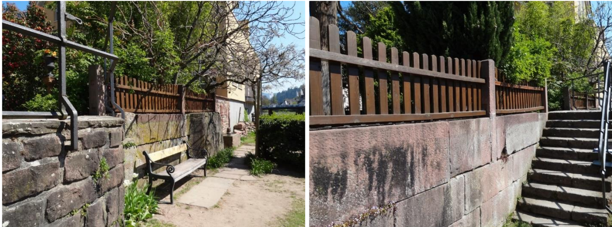
Abbildung 4.3 Ufermauer aus Sandsteinen (links), Treppenanlage als Zugang zur Murg (rechts)
