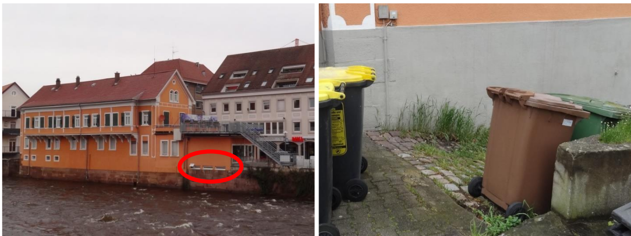
Abbildung 7.1 Mobiler Objektschutz an 3 Fenstern an der Bleichstraße 1 (Flurstück-Nr. 251) (links), Mobiler Hochwasserschutzschlauch am Murgzugang Flurstück Nr. 250 (rechts)
