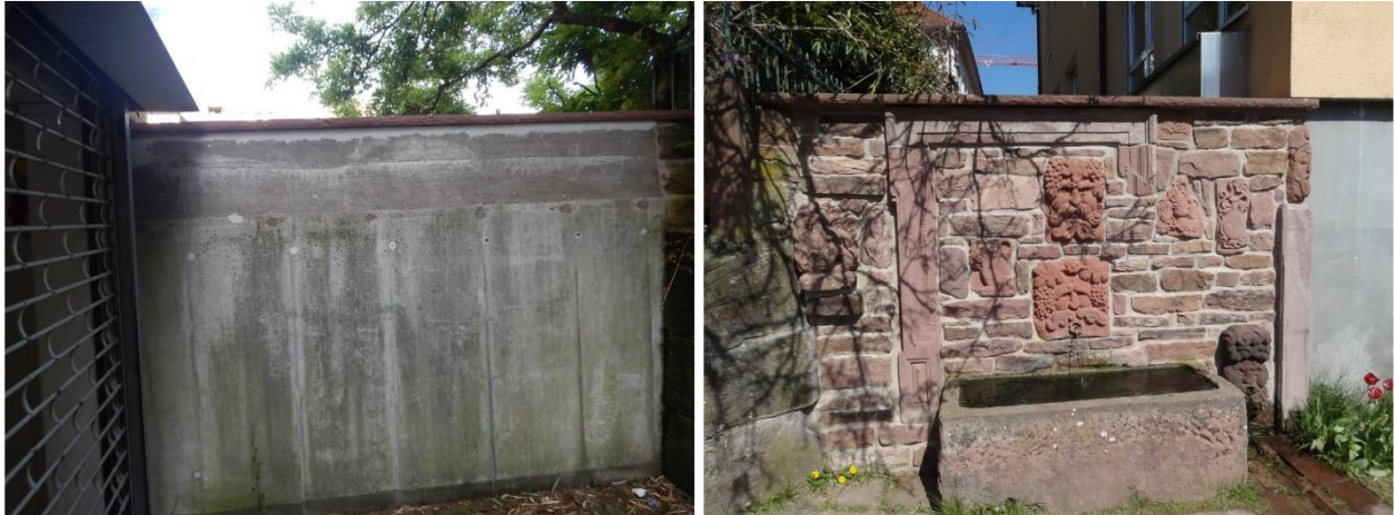
Abbildung 4.2 Ansicht landseitige Stirnwand von Tiefgaragenabfahrt (links), wasserseitige Ansicht der mit Sandsteinen verkleidete Mauer von Tiefgaragenabfahrt (rechts)
