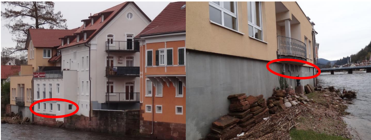
Abbildung 7.2 Mobiler Objektschutz an 5 Fenstern an der Bleichstraße 5 (Flurstück-Nr. 249) (links), Mobiler Objektschutz an der Bleichstraße 7 (Flurstück-Nr. 248) (rechts)
